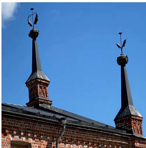
Kuva 14: Verlan tehdasmuseon julkisivun päätykoristeiden pellitykset ovat poikkeuksellisen koristeellisia.
