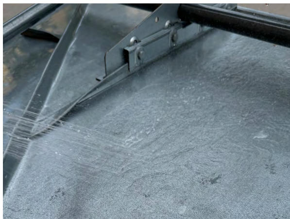
Kuva 31: Harjauksen jälkeen katto huuhdellaan hyvin. (Kuva: Lukas Tuomaala)
