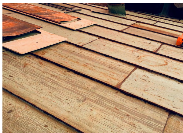
Kuva 11: Patinoitunutta purkutyömaalta talteen otettua kuparikatetta käytetään toisella työmaalla vanhan kuparikatteen paikkaukseen.
