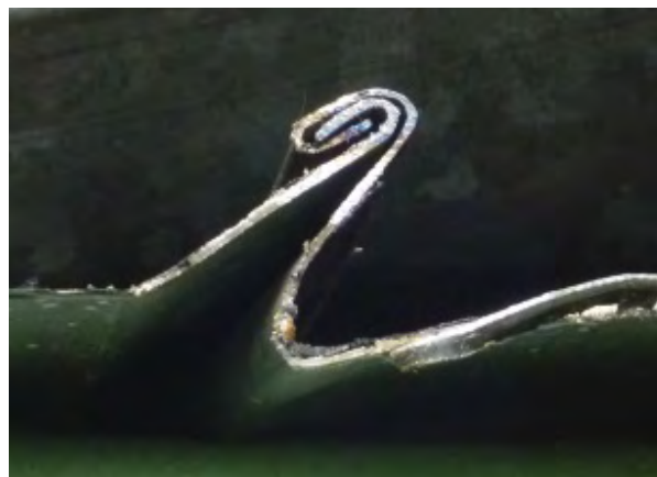
Kuva 3: Levypeltikaton kasinkertainen sauma.
