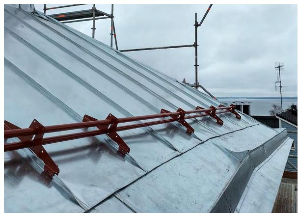
Kuva 24: Lumiaste uusitulla peltikatolla. (Kuva: Pirkanmaan maakuntamuseo)
