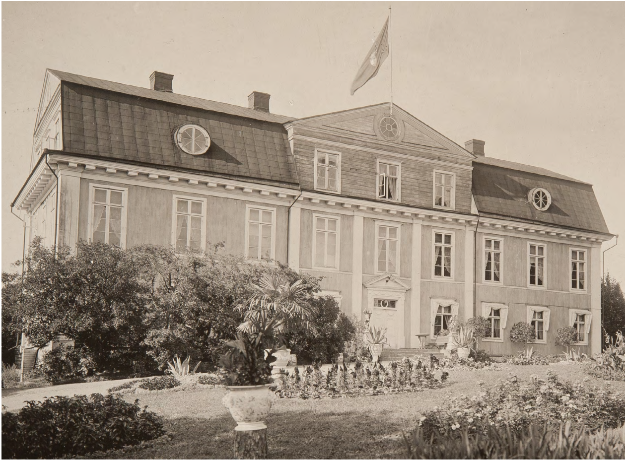
Kuva 12: Mustion kartanon peltikatto Raaseporissa vuonna 1910. Kuvassa näkyy hyvin levypellin arkkikoko.
