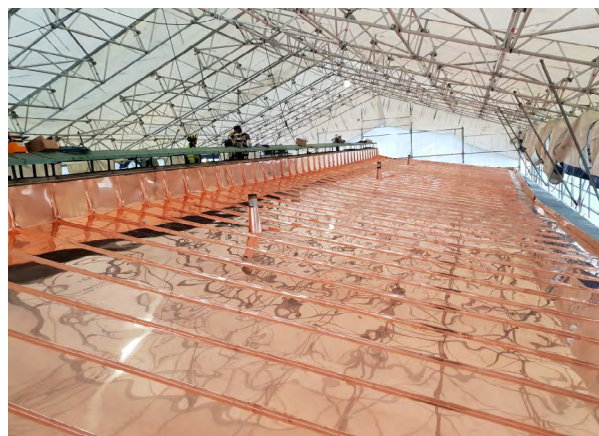
Kuva 10: Kokonaan uusittu kuparikatto (Kuva: Pirkanmaan maakuntamuseo)
