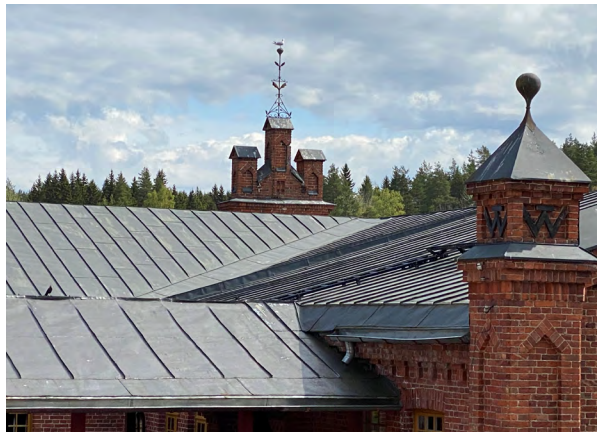
Kuva 13: Verlan tehdasmuseon kattopellitystä.
