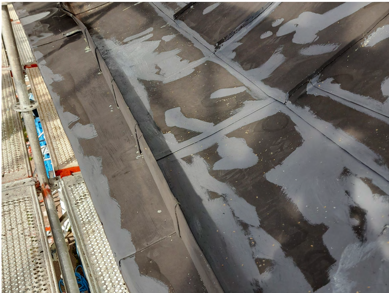
Kuva 25: Peltikatteen ruostekohdat on puhdistettu ja pohjamaalattu.
