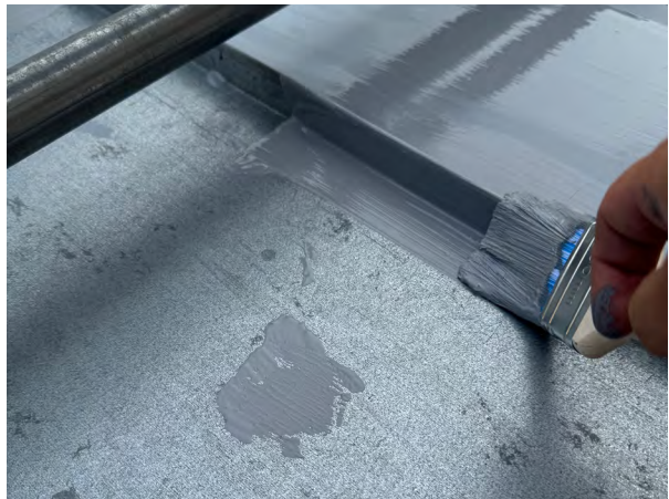
Kuva 32: Pohjamaalaus tehdään, kun puhdistettu pinta on täysin kuiva. (Kuva: Lukas Tuomaala)
