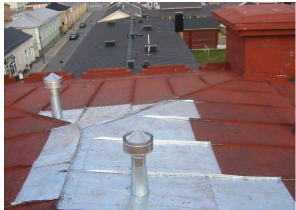
Kuva 22: Vain peltikaton vaurioituneet osat on paikattu. Myös ilmanvaihdon läpiviennit on uusittu. (Kuva: Miika Kurkela)
