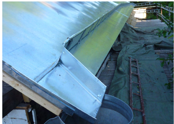
Kuva 23: Korjattu jalkaränni ja veden suppiloon johtava lotokka.
