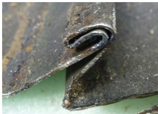
Kuva 4: Valesauma. Sitä käytetään, kun vanha peltikatto, joka on alunperin tehty levyistä, korjataan rullapellillä. Tällöin siihen tehdään saumataitokset, jotka näyttävät kattopinnassa samalta kuin alkuperäinen sauma.
