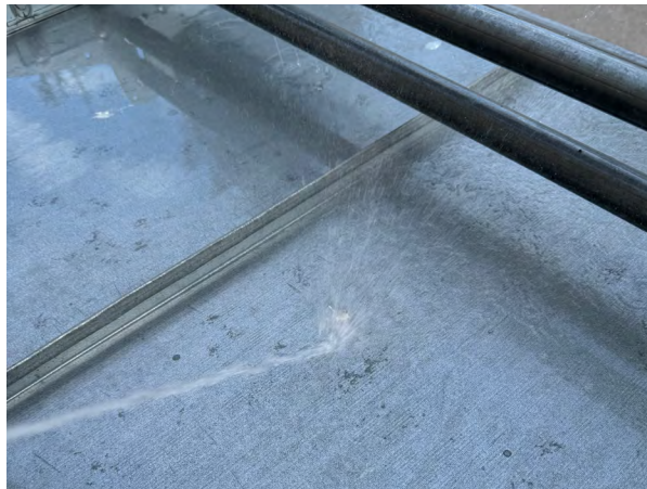
Kuva 29: Uusittu peltikatto voidaan maalata, kun sinkitys on patinoitunut. Ennen maalausta katto pestään. Pesu aloitetaan kastelemalla kattopinta huolella. (Kuva: Lukas Tuomaala)
