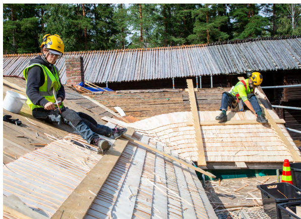
Kuva 24: Pärekkattoa tehdään ylhäältä päin, jolloin tekijä ei ole valmiin pärekatteen päällä.
