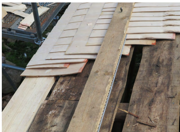
Kuva 21: Pareiden ladonnan aloitus siten, että ensimmäisen rivi tehdään täysimittaisella päreellä.
