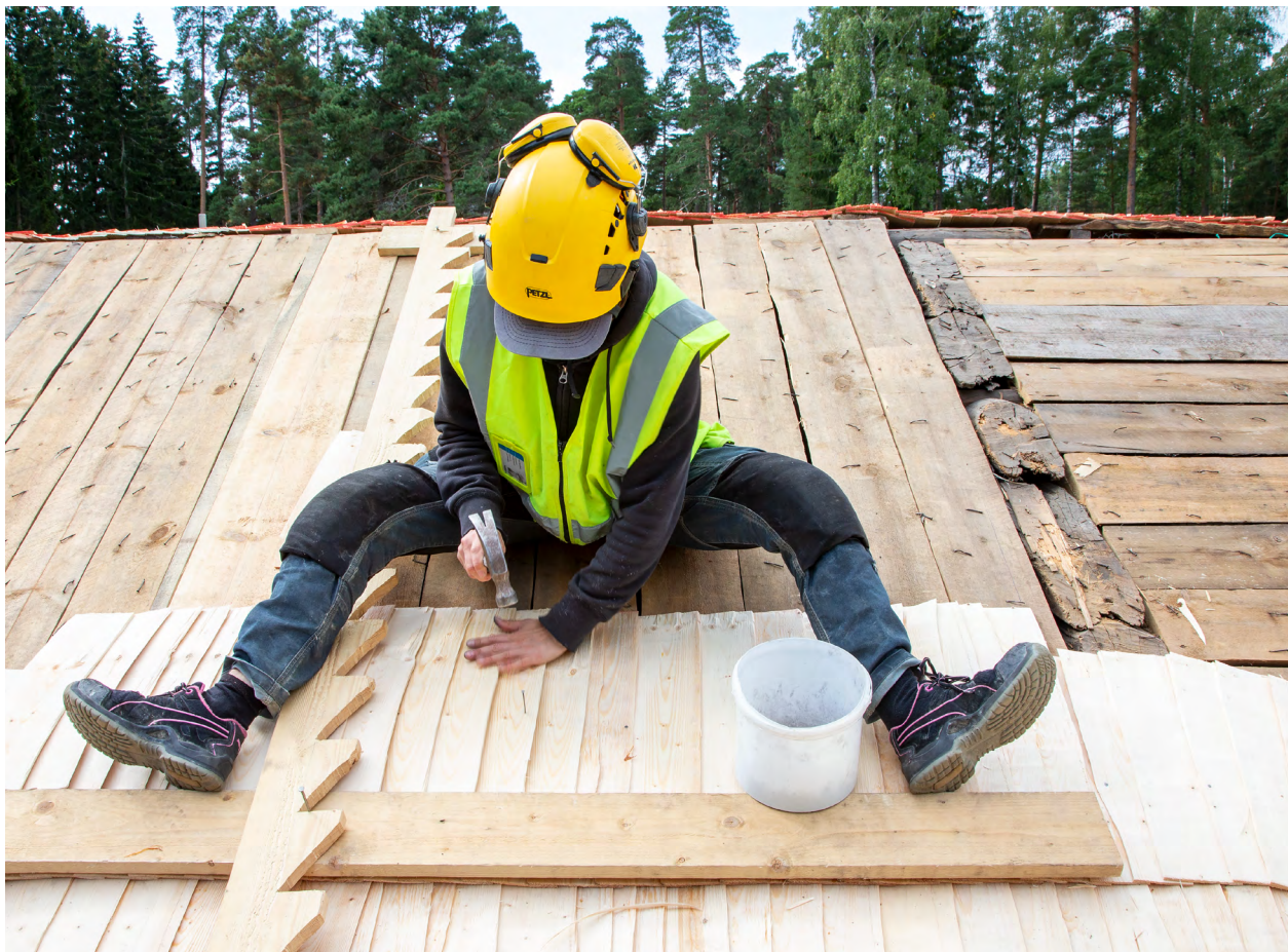
Kuva 3: Pärekaton tekoa Seurasaaren ulkomusessa. Kuvassa näkyy myös hammastettu kampalauta ja linjalauta. Tässä katossa on poikkeuksellisesti umpilaudoitus, joka kulkee harjalta räystäälle, koska se on tehty vuoliaisten päälle. Yleensä ruodelaudoitus on harva, jotta päreet pääsevät kuivumaan altapäin.
