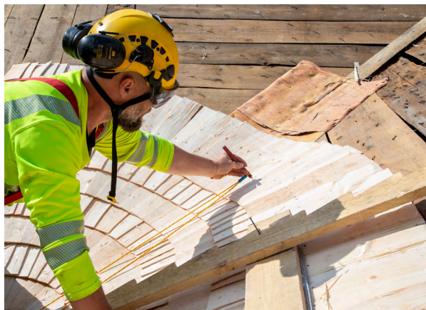
Kuva 27: Sisäjiirin teko pärekatolla. Seuraavan päriverin korkeus merkitään piirtämällä.
