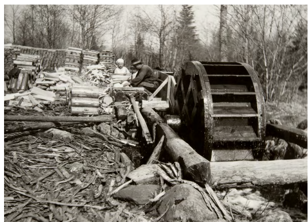
Kuva 6: Vesivoimalla toimiva pärehöylä Tammelan Lunkaassa 1929.
