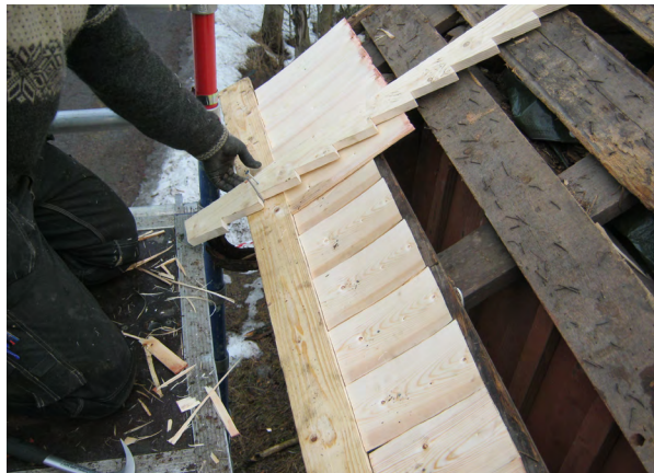
Kuva 23: Päreiden alapääät asetetaan vaakasuuntaista riialautaa vasten. Hammastettu kampalauta on kiinni ylempänä katon lapetta. Riialautaa nostetaan työn edetessä siihen kiinnitetyn naulan avulla seuraavaan hammastukseen, jotta saavutetaan oikea pärerivin korkeus.
