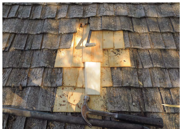
Kuva 11: Vuotokohhta paikataan uusilla päreillä.
