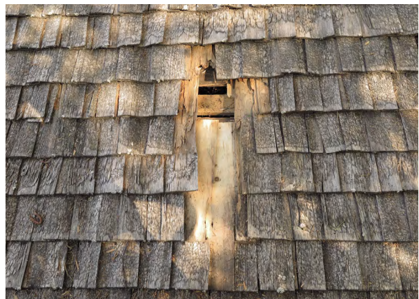
Kuva 10: Paikattavalta kohdalta on poistettu lahot päreets
