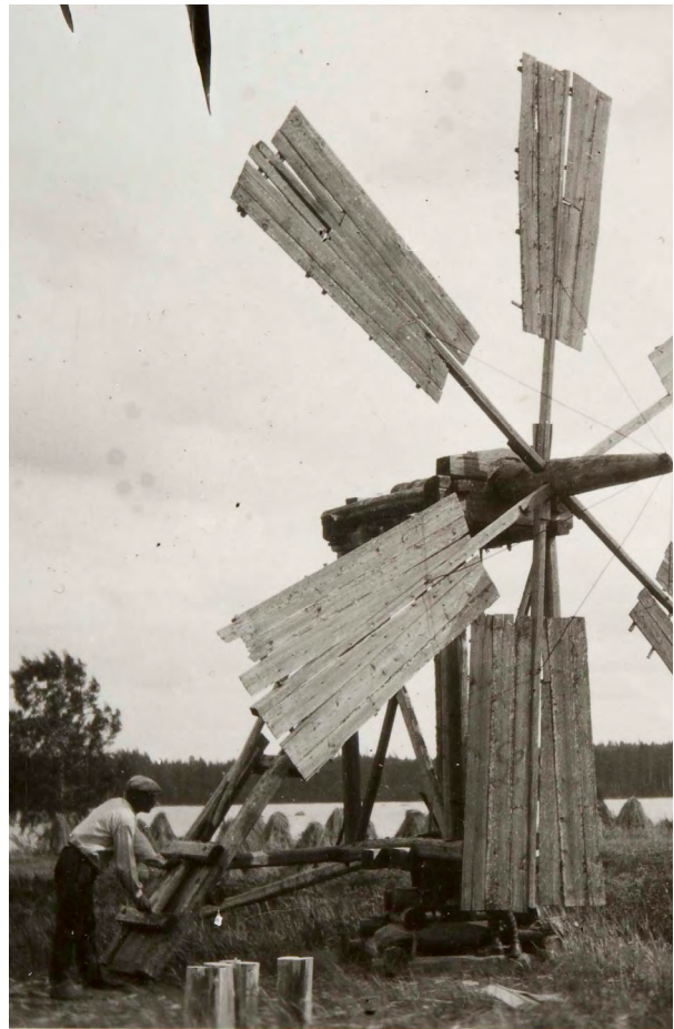
Kuva 5: Tuulivoimalla toimiva pärehöylä Tammelan Letkussa 1928–30.
