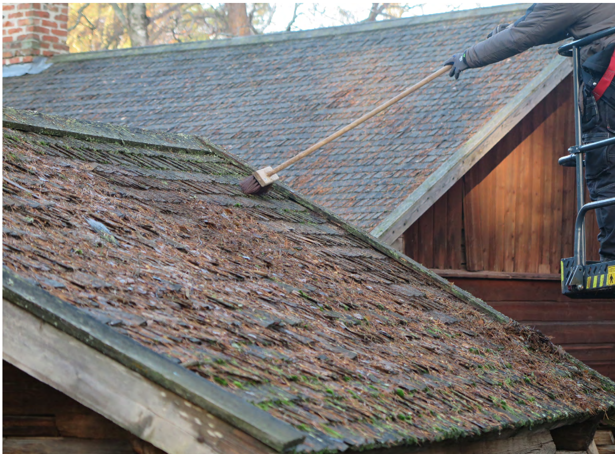
Kuva 7: Pärekaton puhdistusta henkilönostimesta käsin. Harjausliike on tärkeä tehdä ylhäältä alaspäin.
