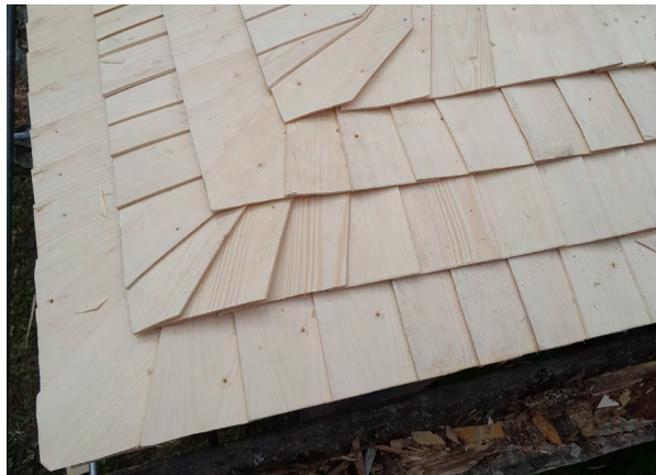
Kuva 26: Ulkojiiri, jossa jiiri on tehty terävällä kulmalla.
